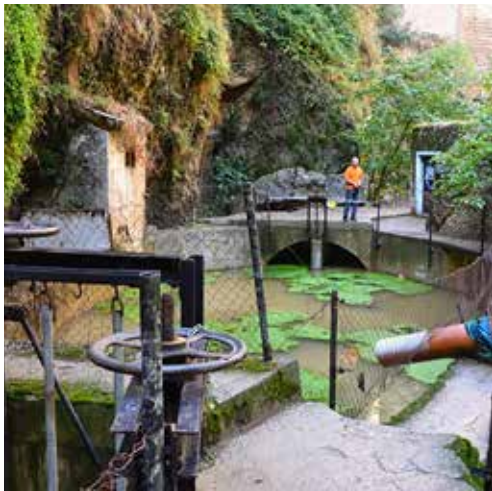
{Plataformas del azud Central Hidroeléctrica }
