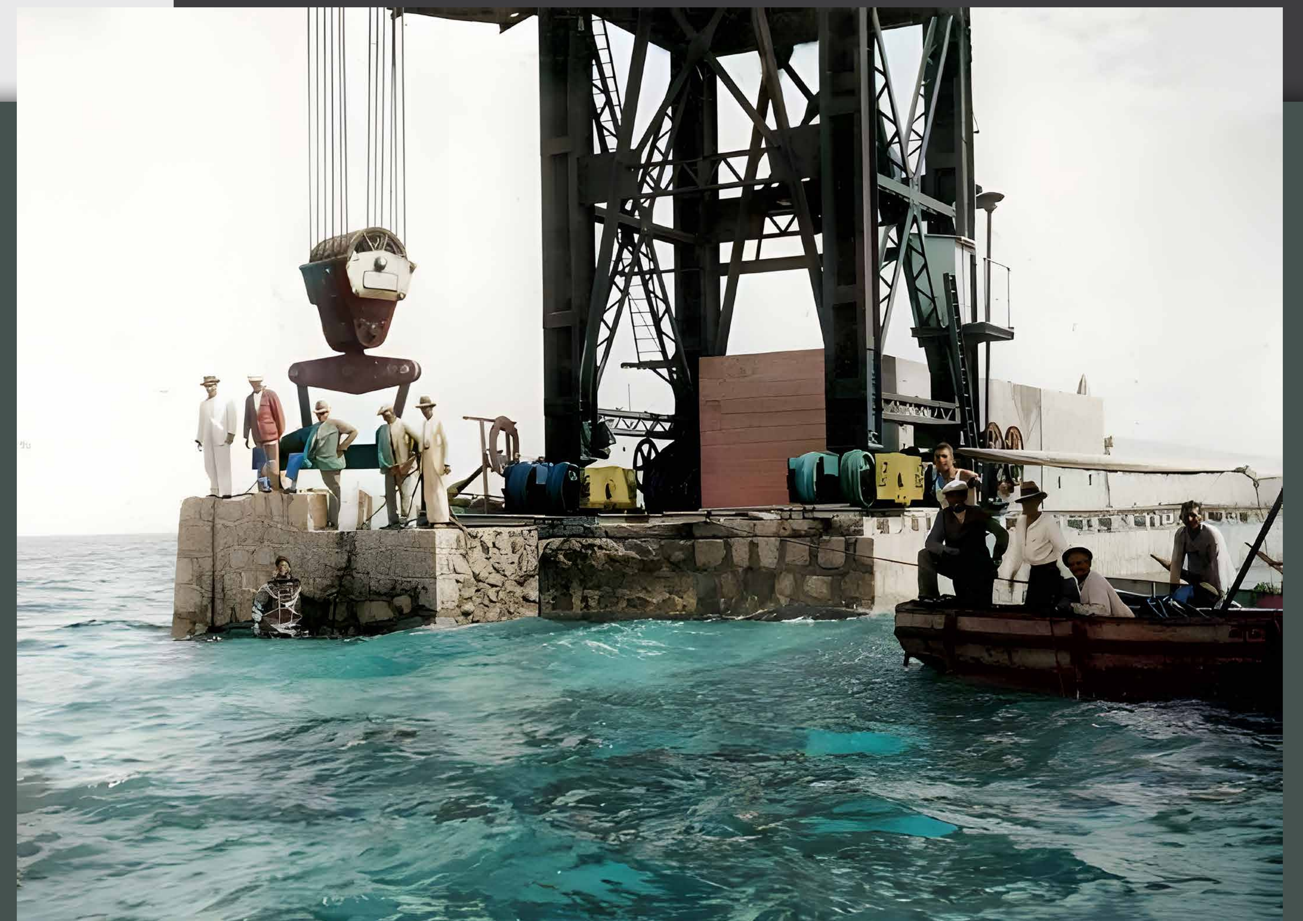
El "Titán" preparándose para depositar un bloque en el fondo la bahía guiado por el buzo. (Archivo de la A.P.B.A.).
