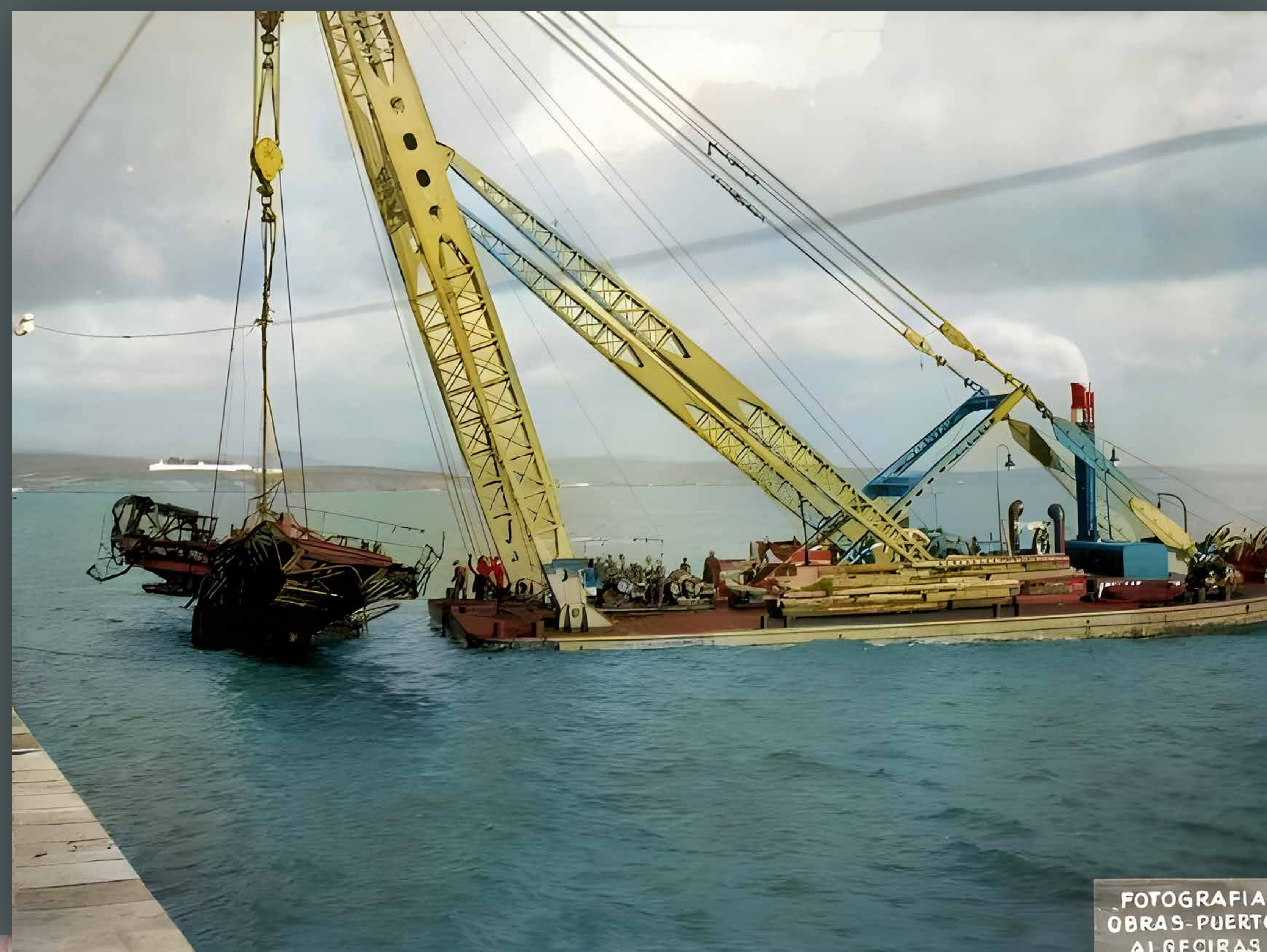
La grúa flotante holandesa "Adelaar" contratada para que sacara del fondo del mar el "Titán" que había sufrido un accidente. Enero de 1932. (Archivo de la A.P.B.A.).
