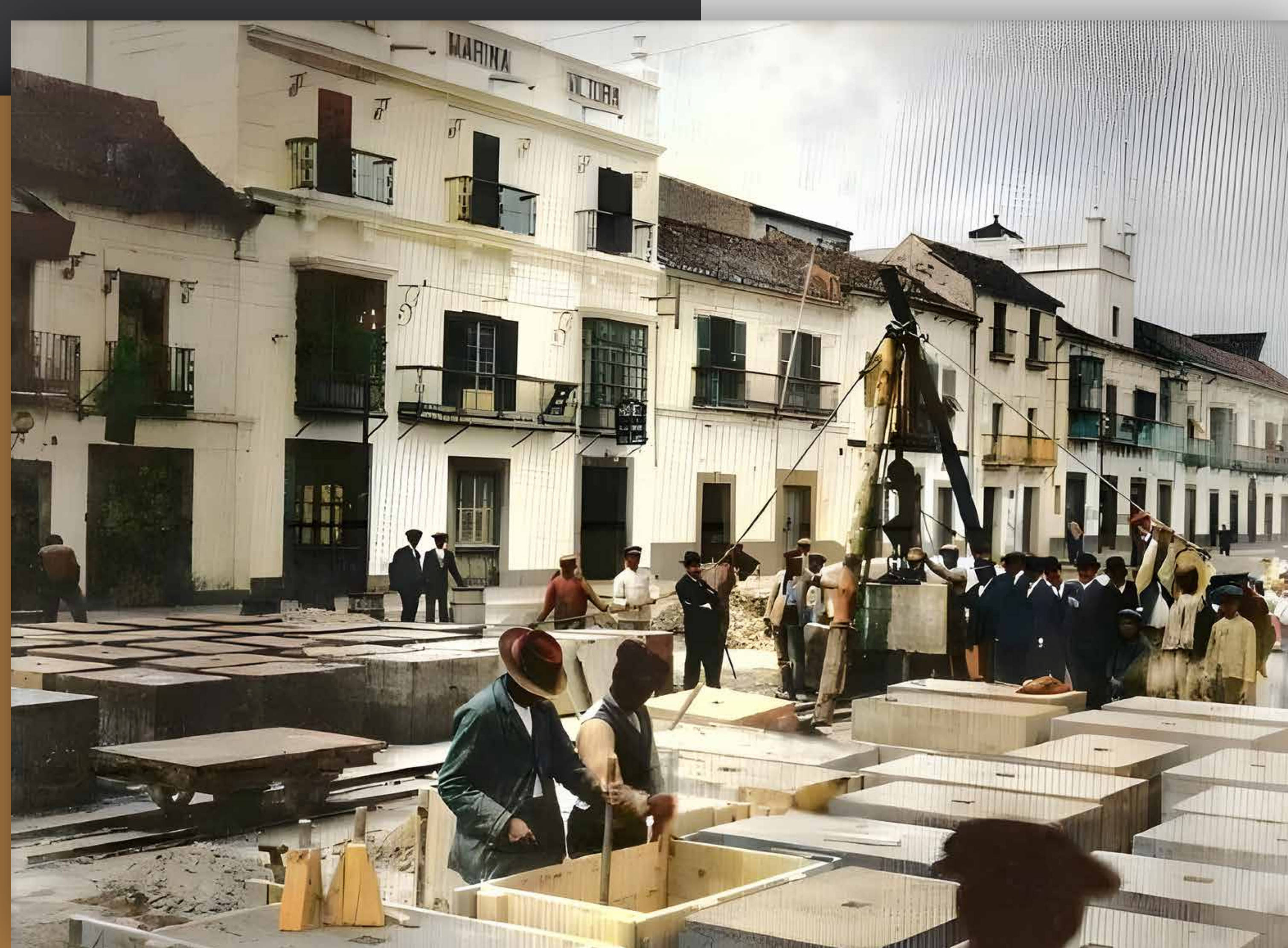
Fabricando bloques de hormigón para la construcción de los muros exteriores del muelle de la Galera. Año 1915. (Archivo de la A.P.B.A.).
