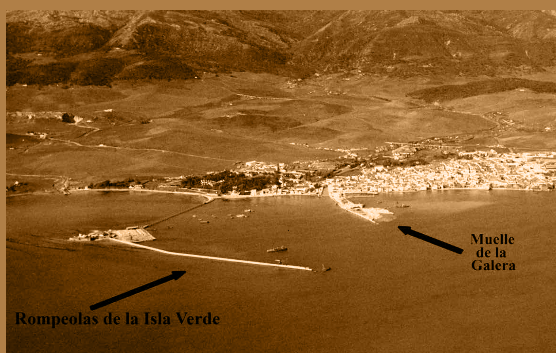
El muelle de la Galera y el Rompeolas de la Isla Verde en construcción. Fotografía aérea tomada en el año 1929 por el piloto de la R.A.F. señor Armour.
