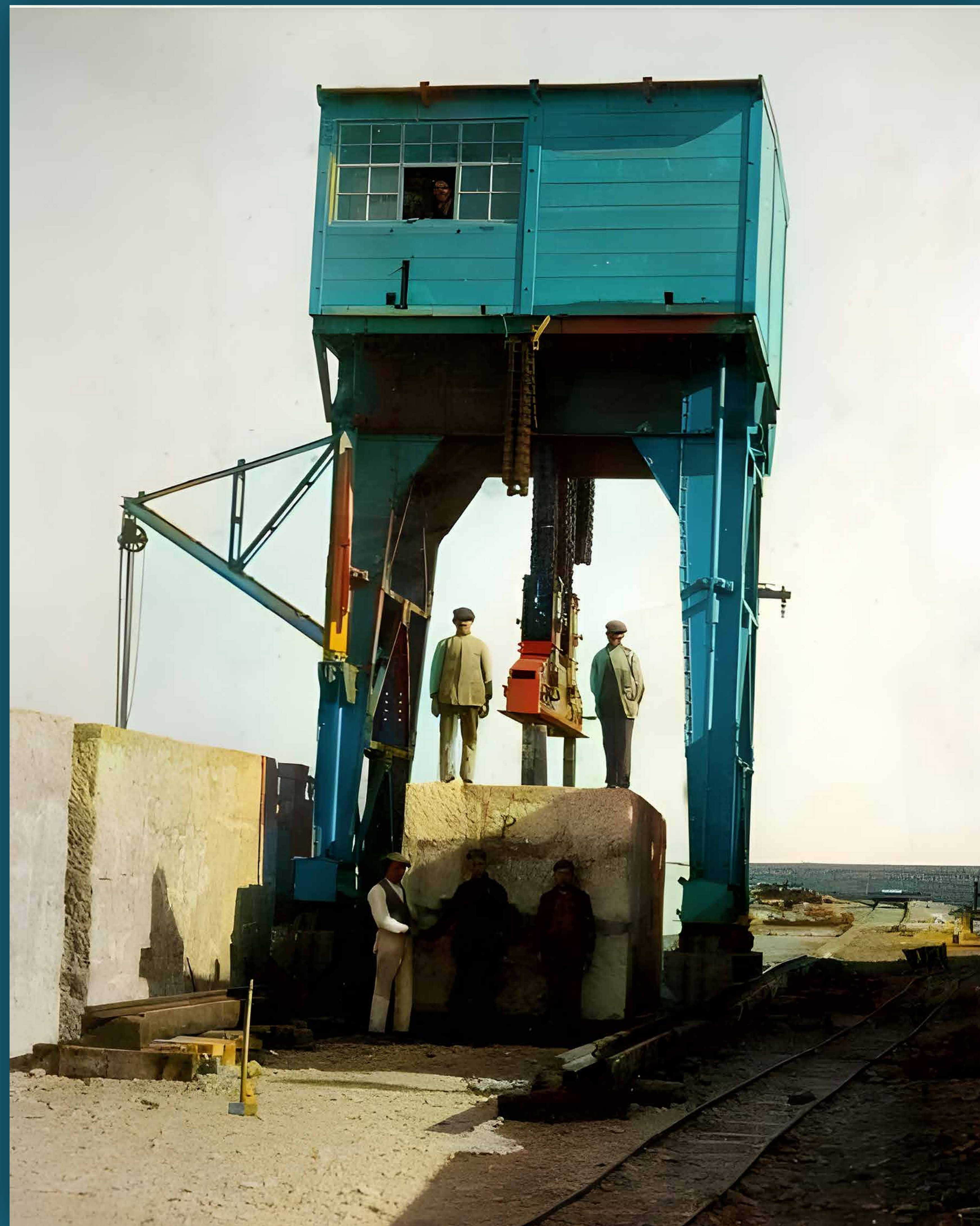
La grúa-polipasto "Goliat" preparada para transportar un bloque. (Archivo de la A.P.B.A.).
