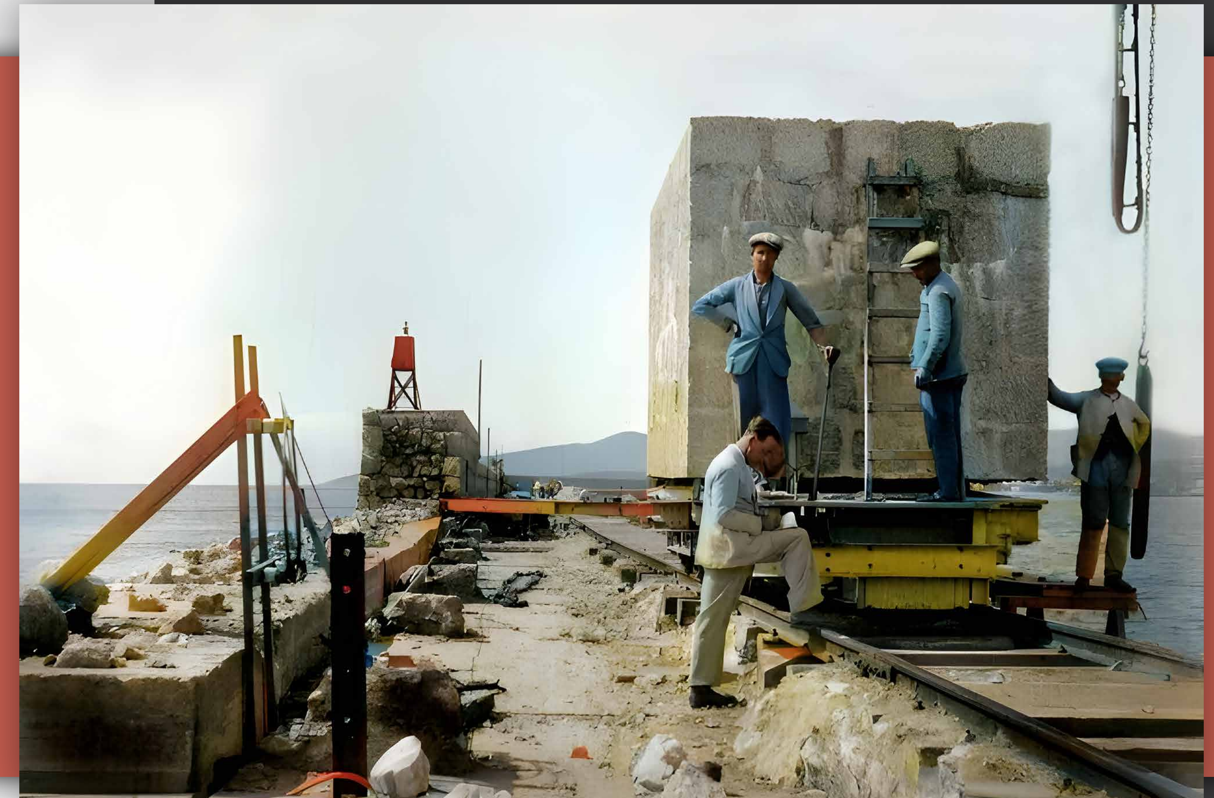
El carro transbordador portando un bloque por la vía del dique hasta las proximidades del "Titán". Véase, a la izquierda de la fotografía, el espaldón del rompeolas en construcción. (Archivo de la A.P.B.A.).
