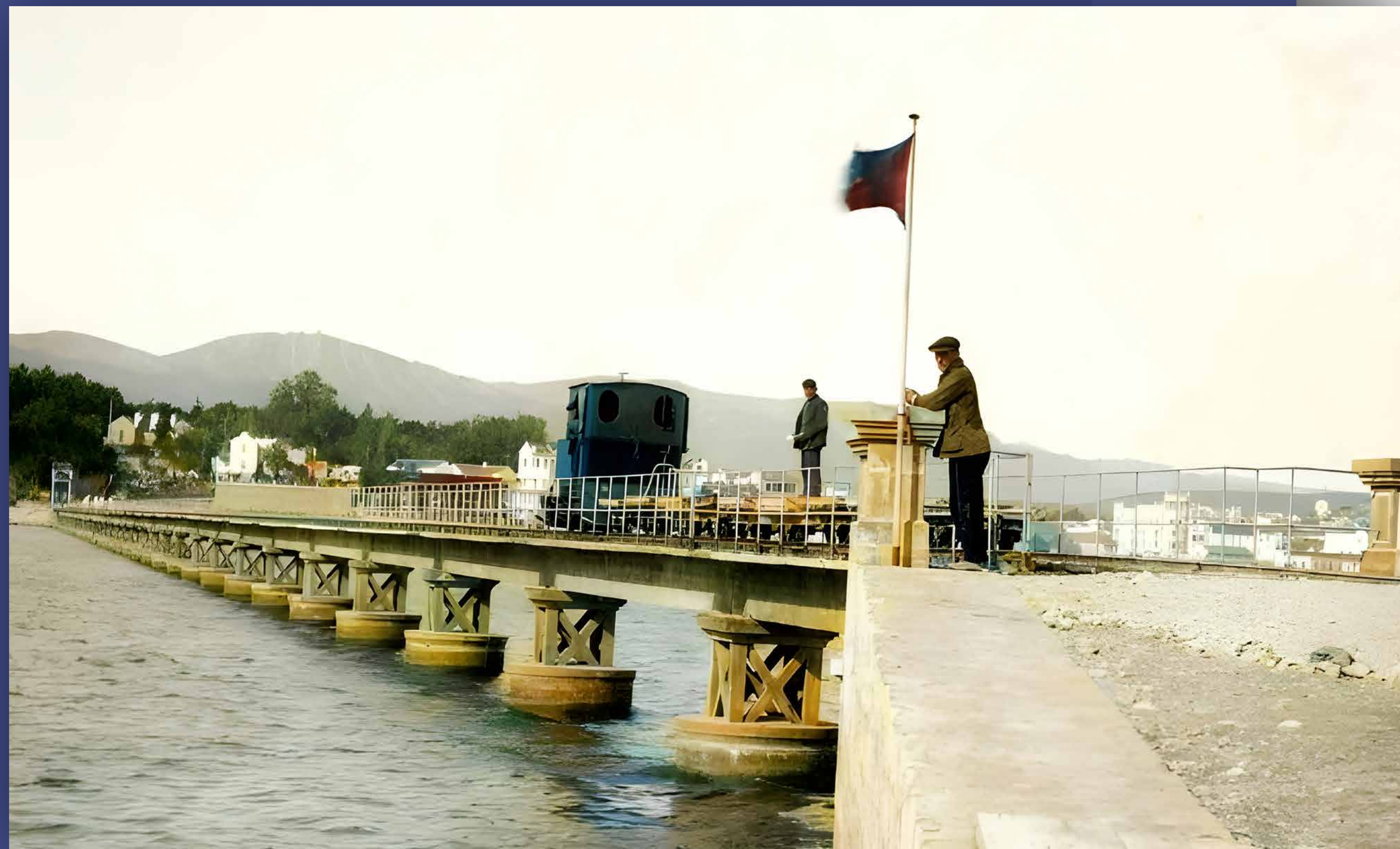
El puente ya terminado y un tren de vagonetas cruzándolo en dirección a La Cantera de los Guijos. Año 1930. (Archivo de la A.P.B.A.).
