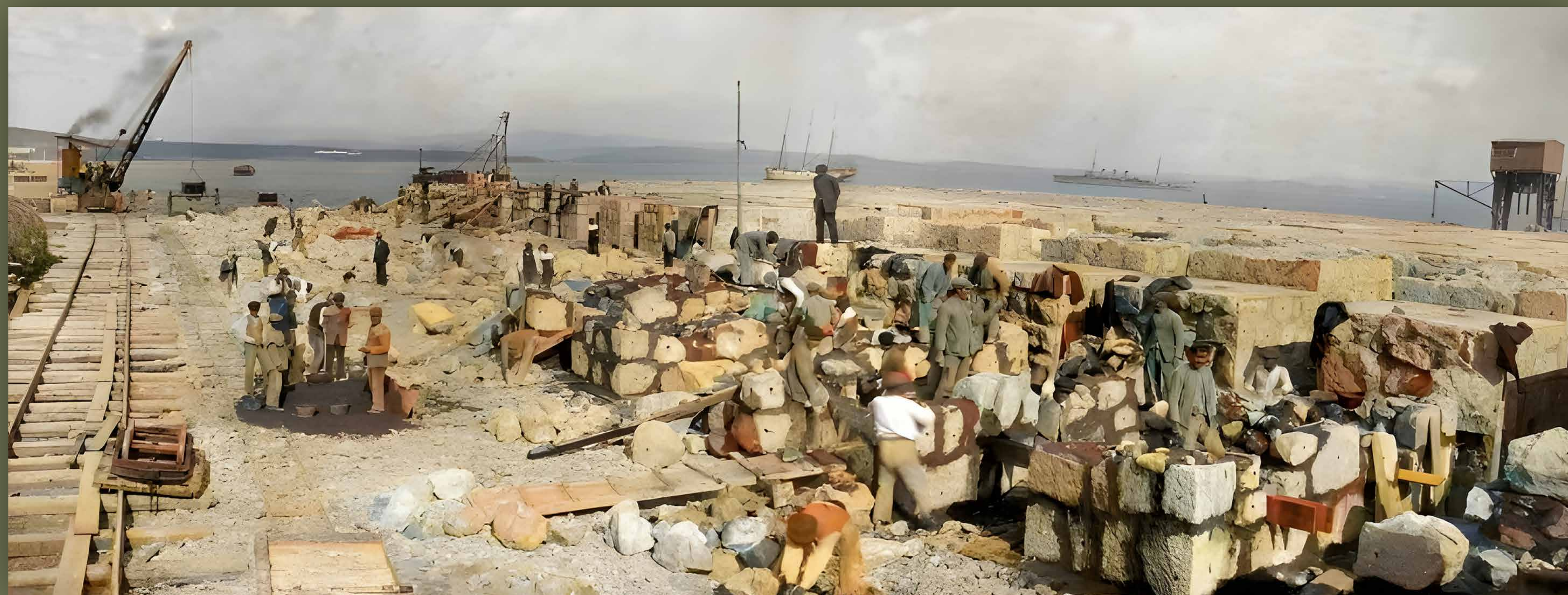
Taller de Bloques instalado al noroeste de la isla. Los bloques de mampostería se fabricaban con fragmentos de roca caliza de la Cantera unidos con cemento apropiado para resistir la inmersión en agua de mar. Fotografía de 1926. (Archivo de la A.P.B.A.).
