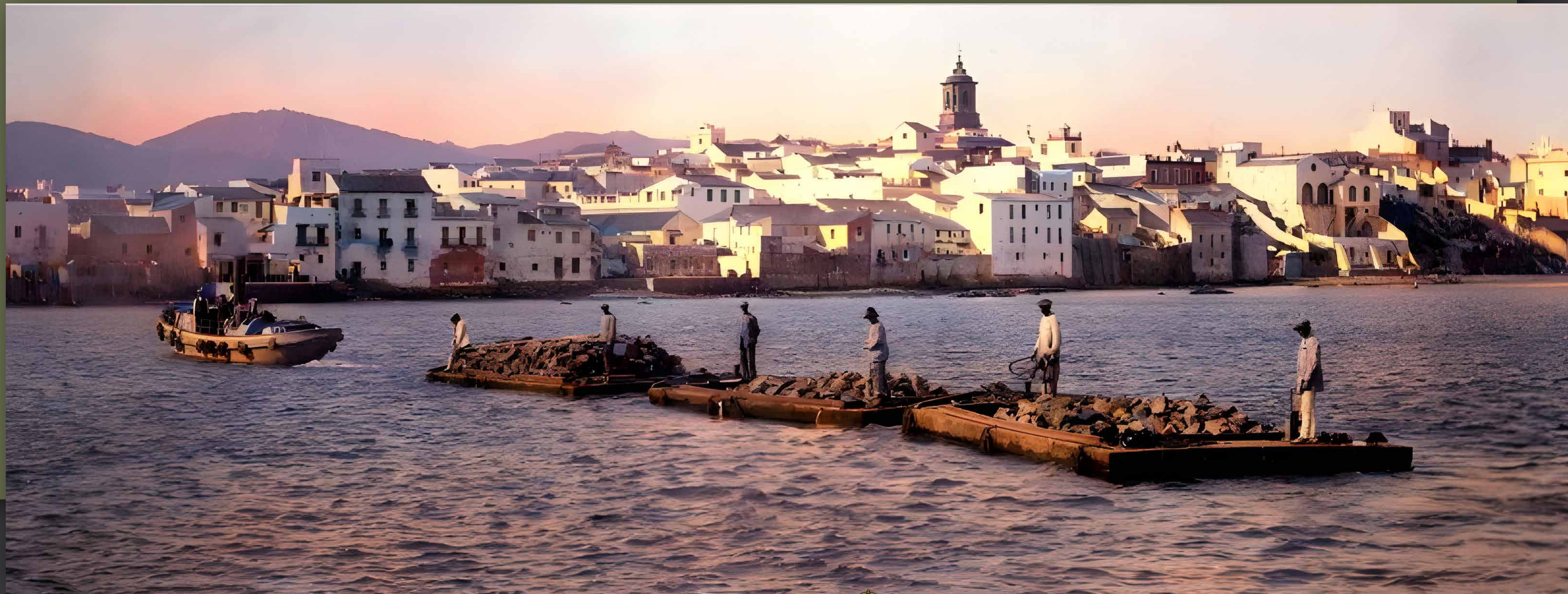
Chalanas transportando piedras para las obras del muelle de la Galera. Fotografía tomada en 1915. (Archivo de la A.P.B.A.).
