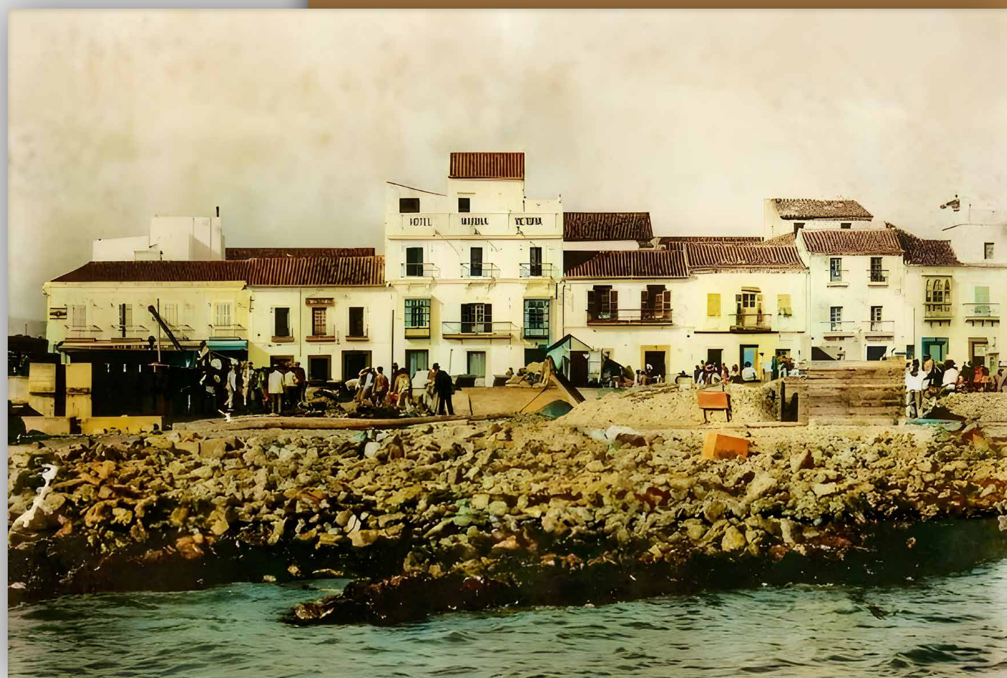
Primeros rellenos en las obras del muelle de la Galera. Año 1914. (Archivo de la A.P.B.A.).
