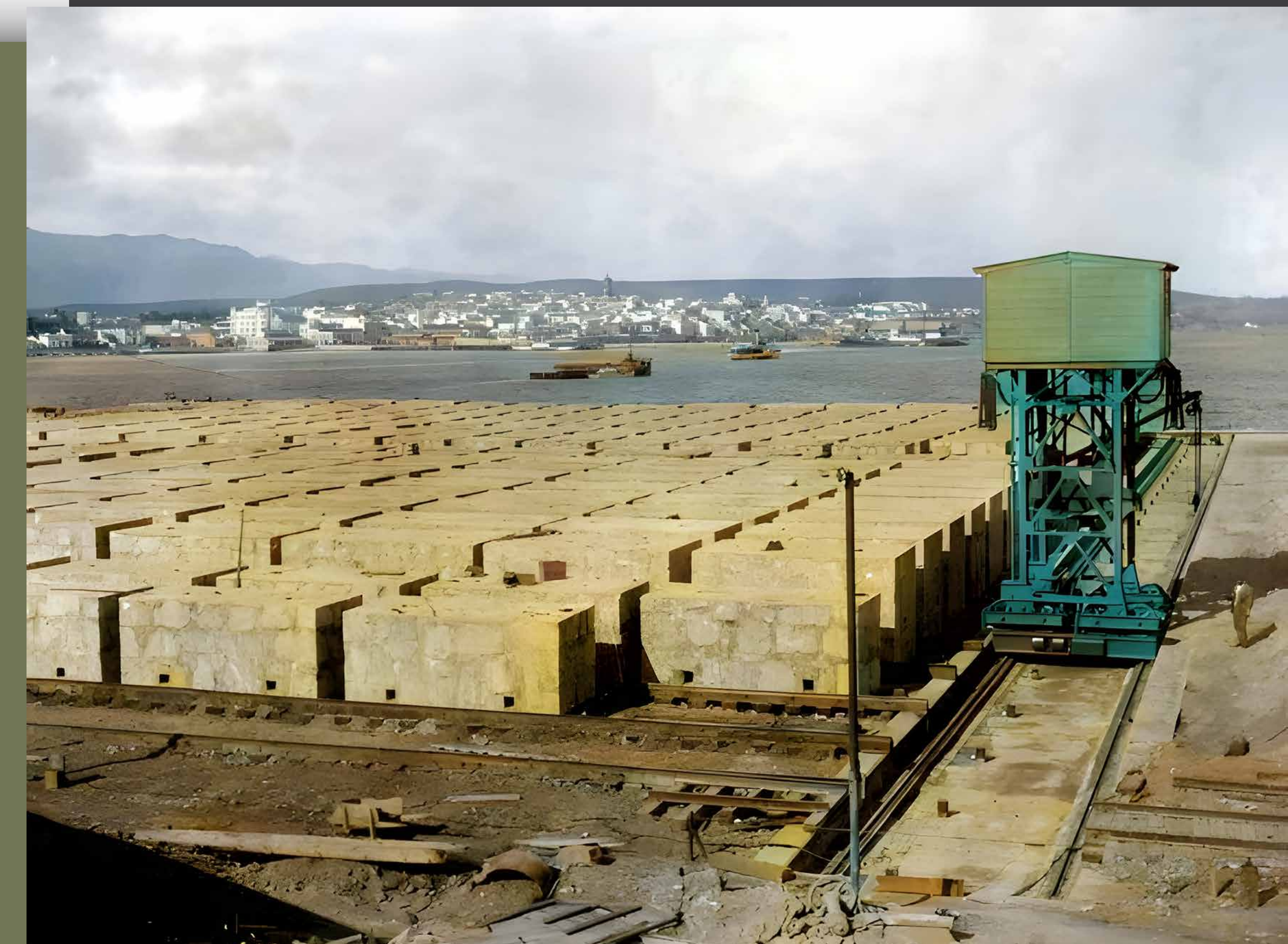
Vista parcial del taller de bloques. Véase el "Goliat" y las vías para su desplazamiento, tanto longitudinal como transversal. Hacia 1927. (Archivo de la A.P.B.A.).
