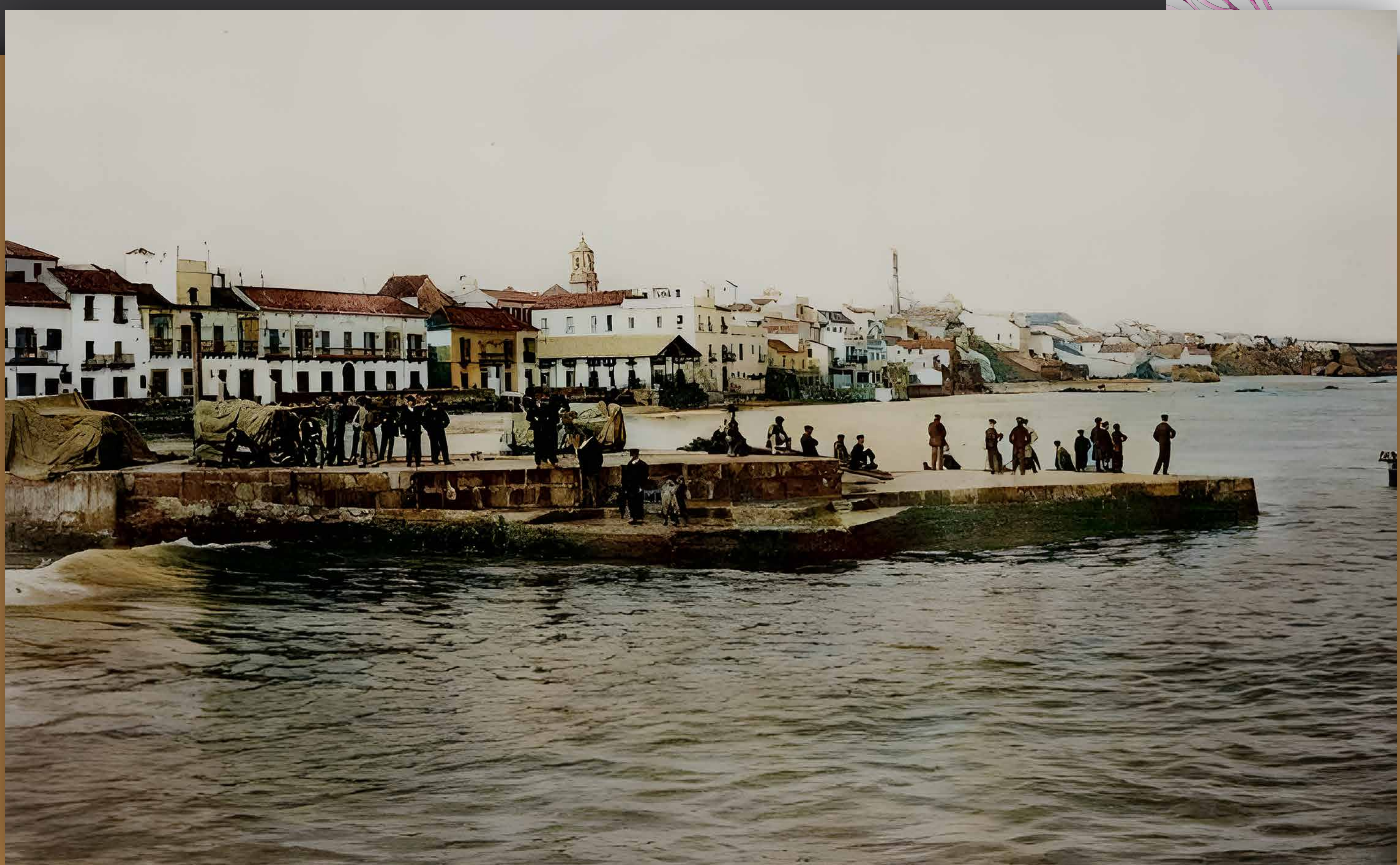
Muelle Comercial o Viejo construido por el Ayuntamiento en el año 1875.
