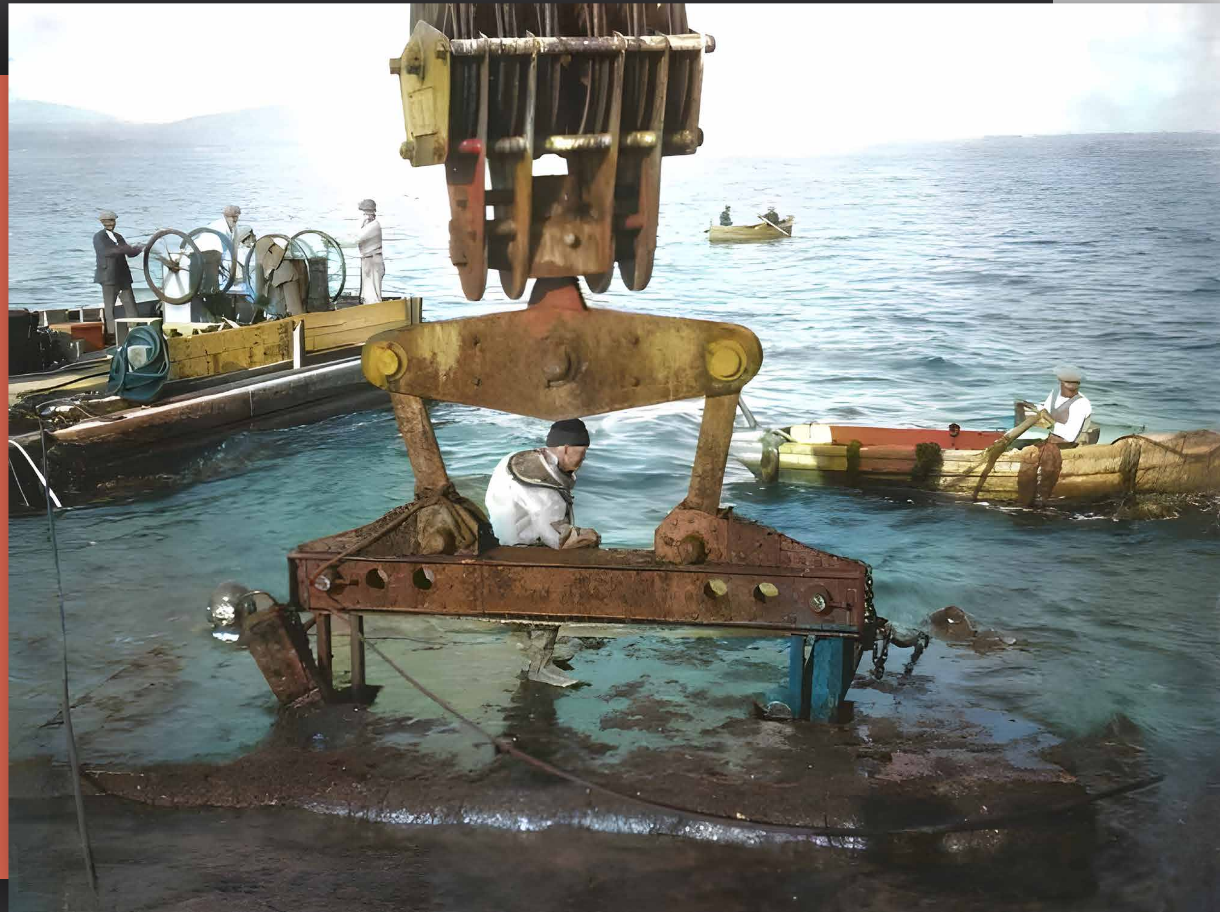
Uno de los bloques es depositado por el "Titán" en el agua. Sobre él, el buzo que participaba en las maniobras de su colocación en el fondo de la bahía. (Archivo de la A.P.B.A.).
