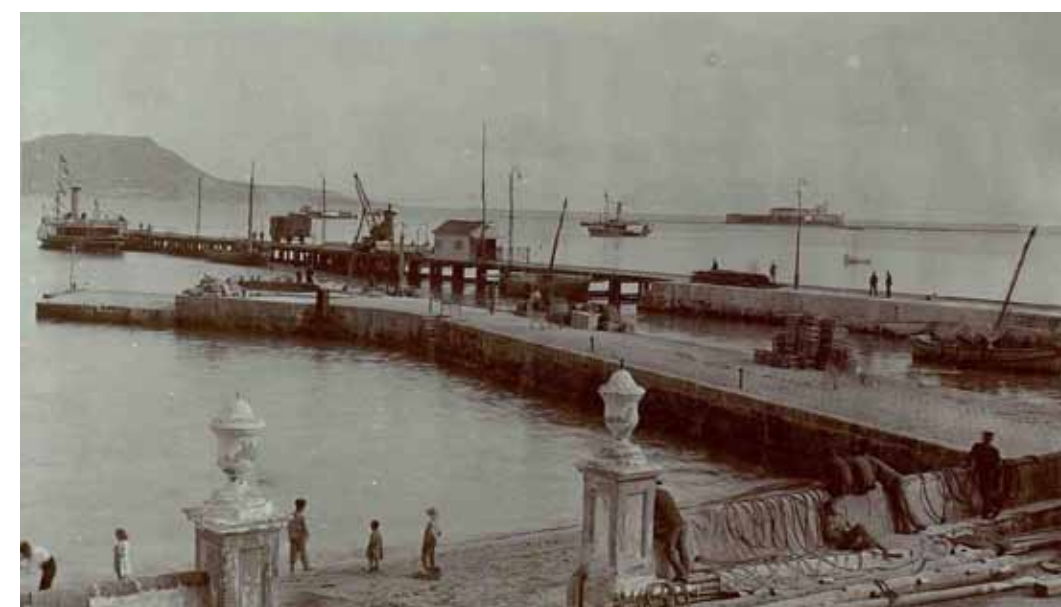
Vista general del muelle, Puerto de Algeciras.
