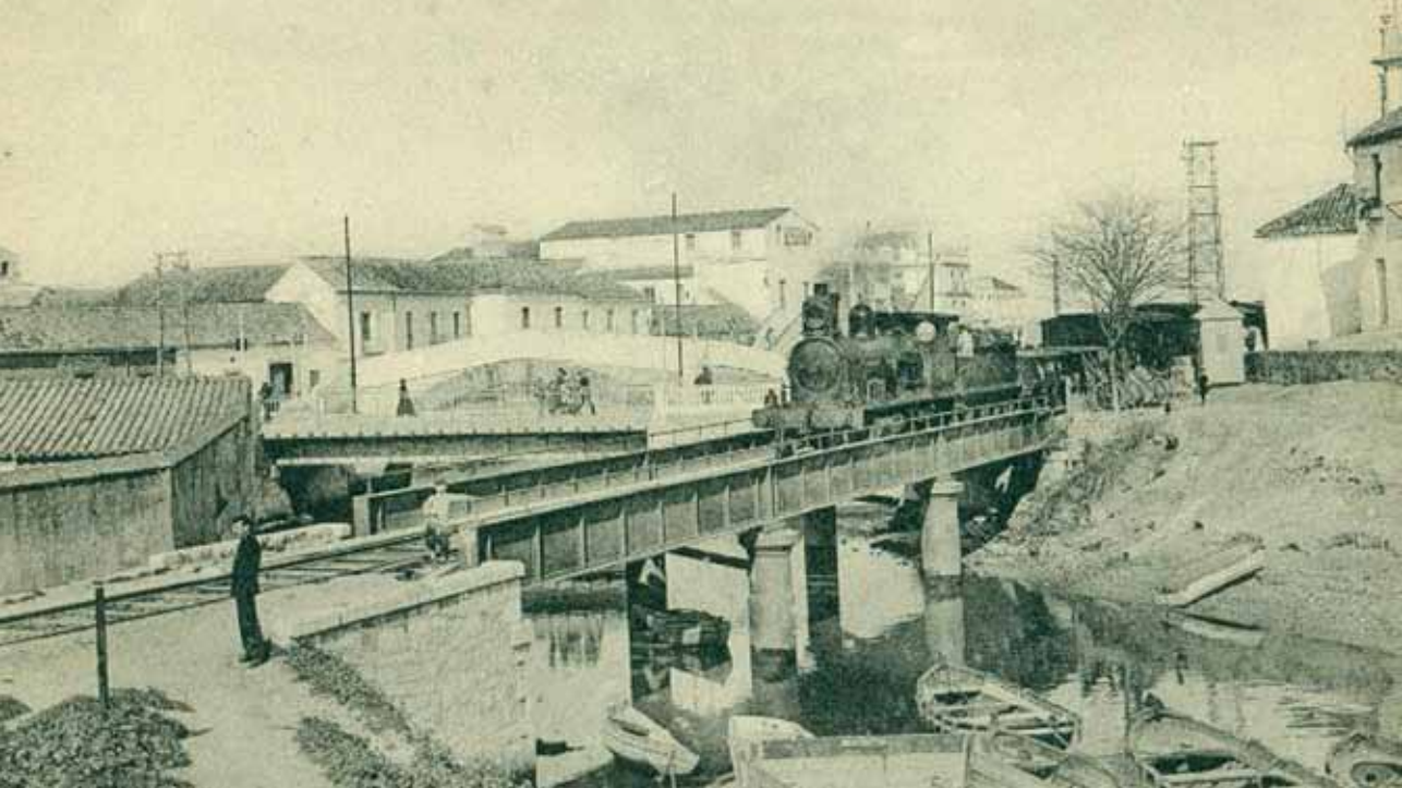
Los tres puentes sobre el río de la Miel. Algeciras, hacia 1910
